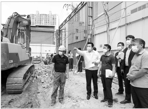
구로구의회 박동웅 의장이 지난 25일 태풍 '바비'가 북상함에 따라 재난상황을 사전에 대비하고자 관내 주요 공사현장을 방문해 안전점검을 실시했다. (개봉2동 주민센터 신축공사 현장, 개봉고가 공사 현장) (사진은 현장상황과 태풍대비 시설안전 점검상황에 대해 설명을 듣고있다)
